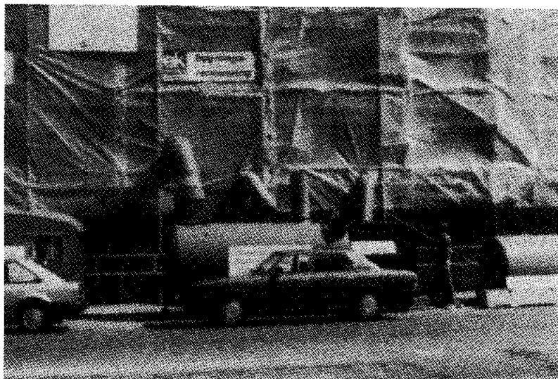
Ejendommen er pakket ind i et telt, og varmekanonnen sender ca. 55 grader varm luft ind, hvilket dræber hussvampen.
